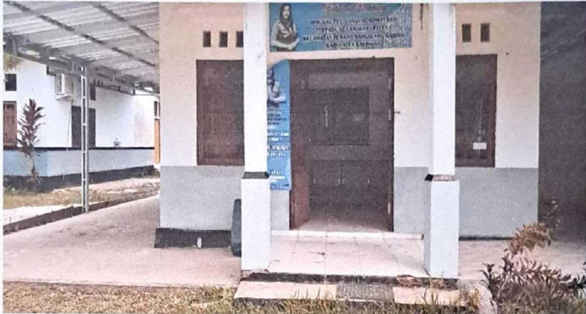
Gambar 2. Gedung Pelayanan (Tampak Depan)
